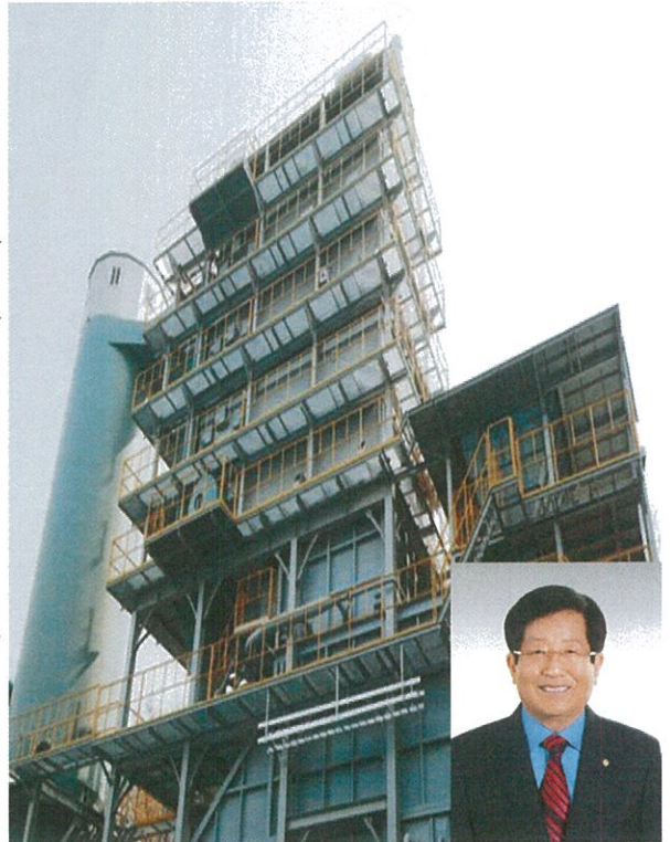
▶ (주)국인산업의 에너지생산 주시설인 보일러 전경(박무웅 대표이사)
